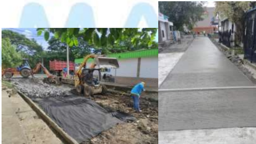
Figura 48. Obra comuna 4, 6 y 7
