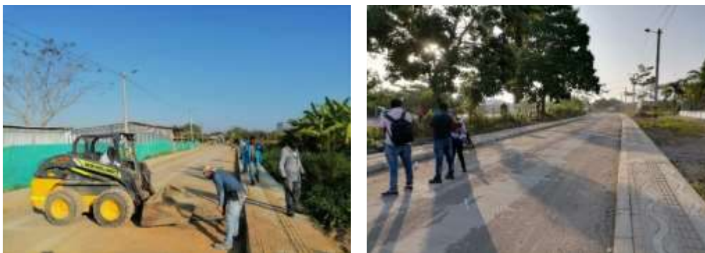
Figura 43. Intervención Obra Mandala – Canta Claro
