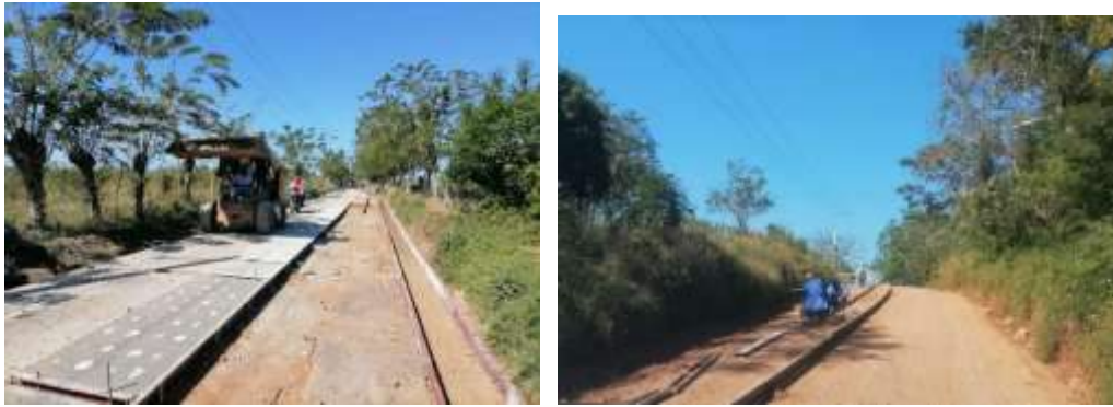
Figura 47. Intervención Obra Santa Clara – Rural
