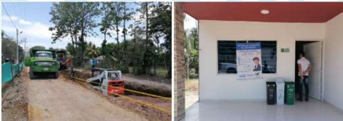
Figura 42. Intervención Obra los Pericos - Rural
