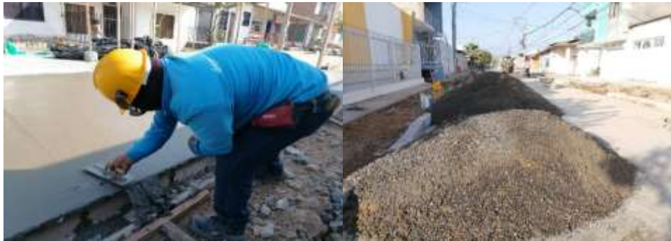
Figura 41. Intervención Obra Nueva Belén – Nueva Jerusalén
