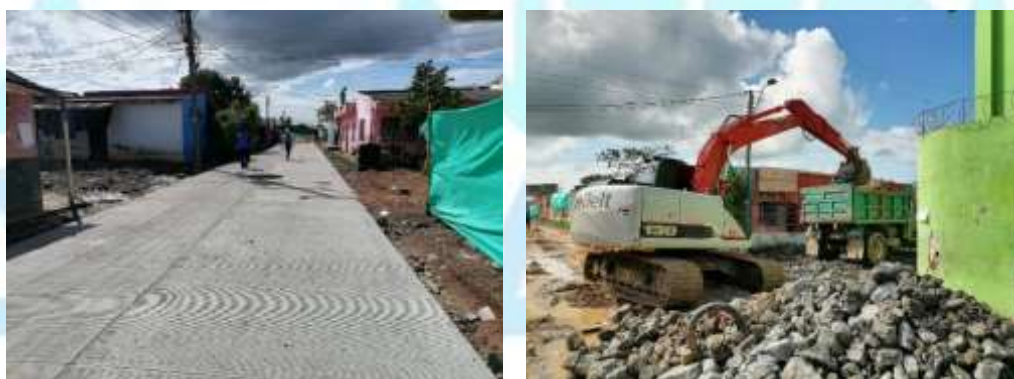
Figura 44. Intervención Obra Canta Claro
